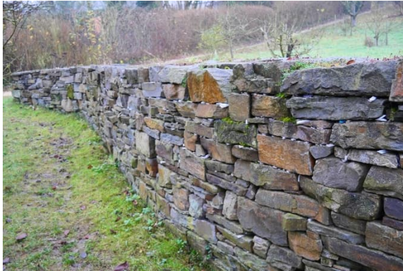
Klagemauer im Kloster Arensburg
